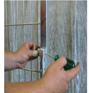
Toranschlag mit Bohrschrauber
